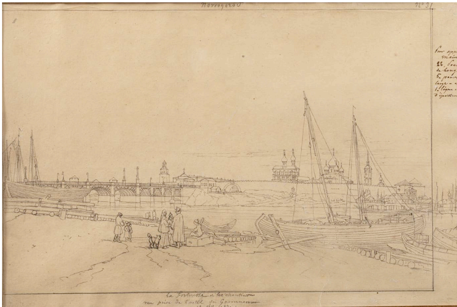
Planche 31 : Dessin sur calque - À noter : Nowogorod. - La Forteresse et les chantiers - vue prise de l'hôtel du Gouvernement (18 8bre ?) + annotations
