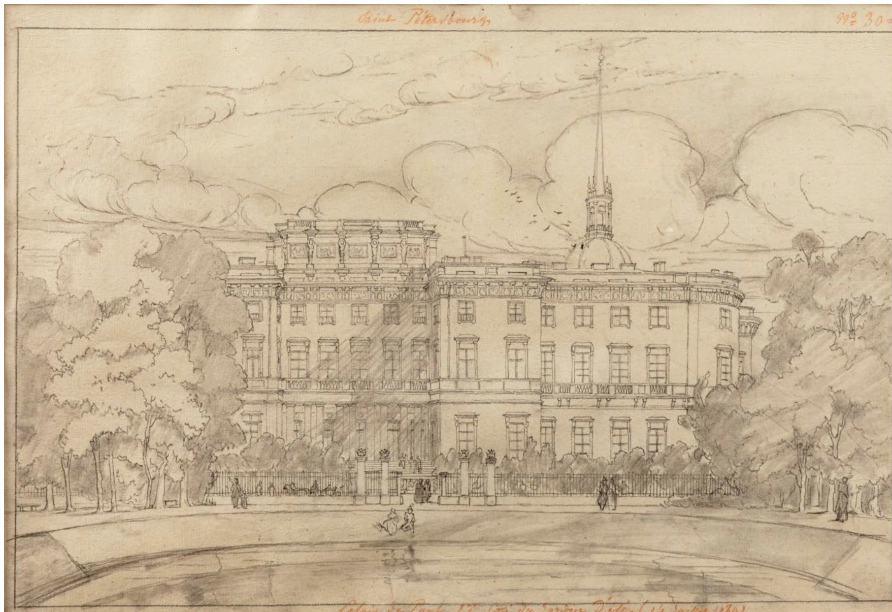
Planche 30 : Dessin sur calque - À noter : Saint Péterbourg - Palais de Paul 1er (côté du jardin d'été) 14 Juillet 1839)
